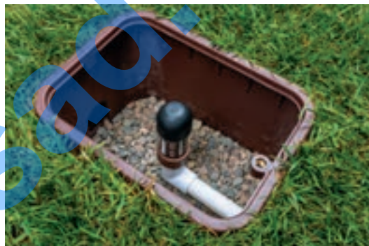
Nainštalovaný vzduchový/vákuový poistný ventil
