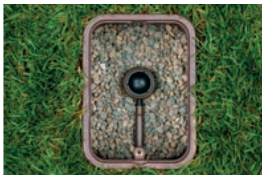
Nainštalovaný automatický preplachovací ventil
